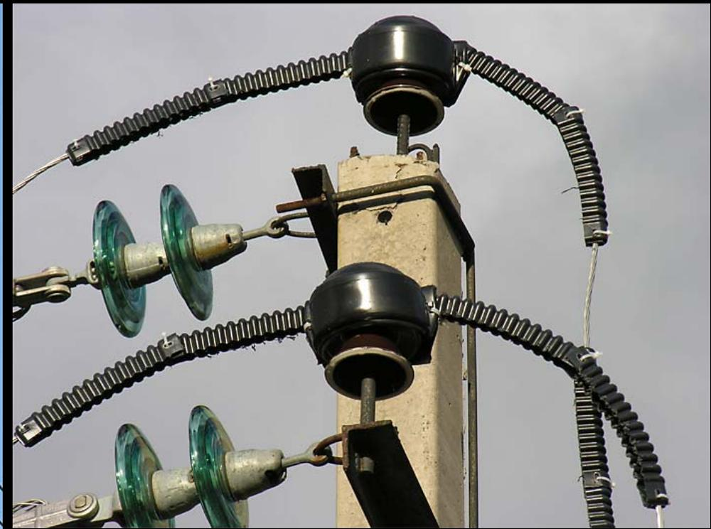
ПЗУ Нижегородского производства из АБС-пластика для штыревых изоляторов ШС-10, ШФ-10 и ШФ-20 с боковой вязкой провода .
