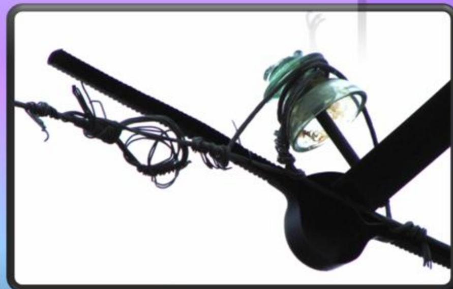
Нестандартные соединения проводов, образующие узловые утолщения и выступы, не позволяют применить ни одно из существующих защитных устройств
