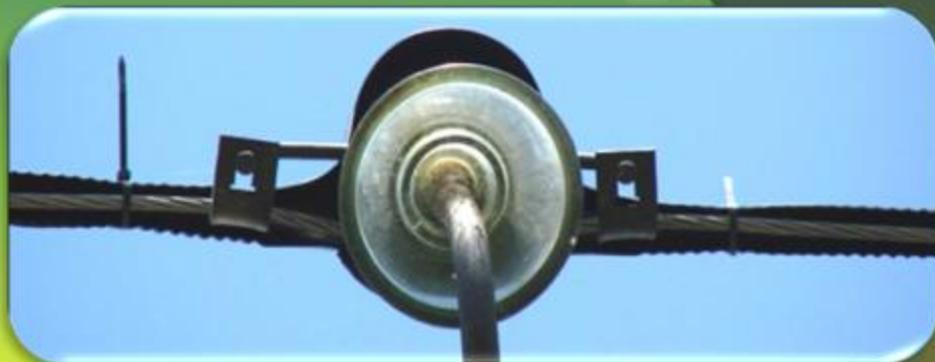
**Недопустимое использование ПЗУ-6-10кВ (для промежуточных опор с боковой вязкой провода) вместо требуемых специальных ПЗУ-6-10кВ-С для промежуточных опор с креплением провода на скобах**
