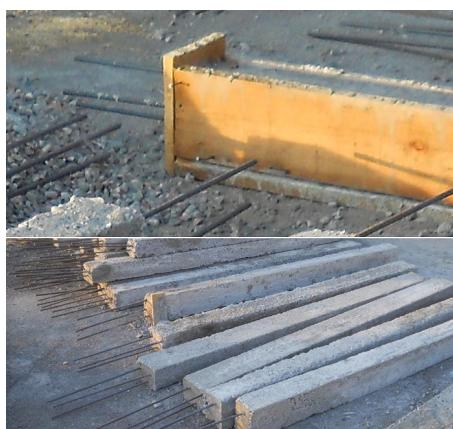
заглушки, в одной из которых сверлятся отверстия для вывода прутов каркасной арматуры (см. рис. 11). Сваренная в нескольких местах перемычками арматура вставляется в опалубку и заливается бетоном.
