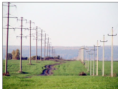
ЛЭП (6–10кВ) с железобетонными опорами в Нижегородской области. Фото А. Машыны
