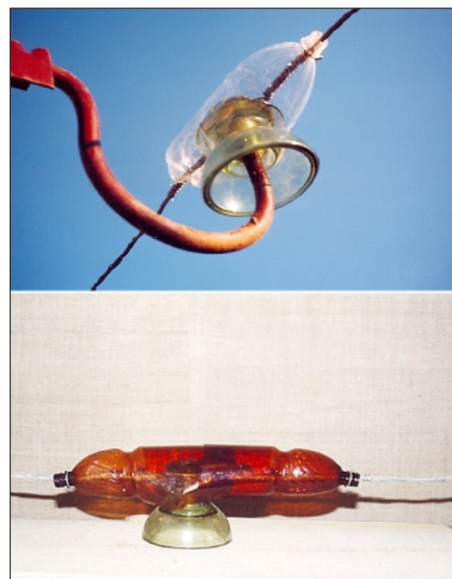
Варианты самодельных ПЗУ, изготовленных из ПЭТ-бутылок. Фото А. Салтыкова
