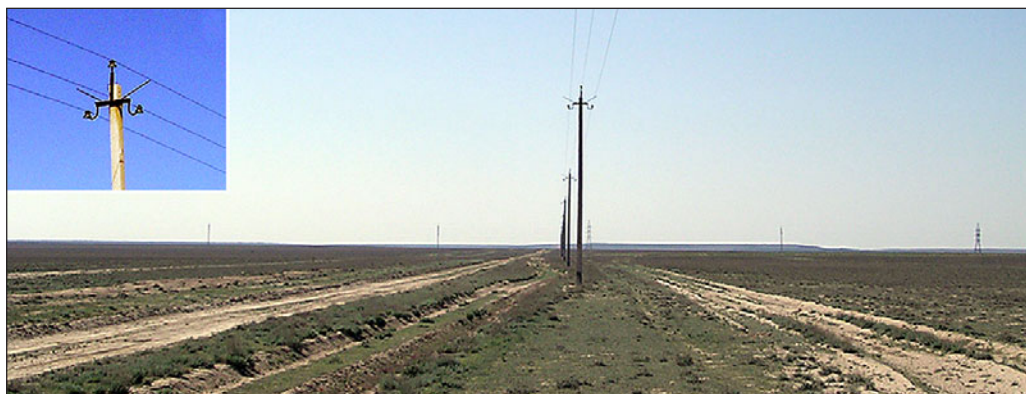
Рис. 2. Птицепроопасная ЛЭП. Тип 1. Фото И. Карякина
