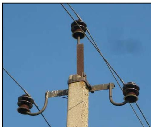
Оголовок птицепопасной ВЛ 10 кВ с неизолированными проводами. Фото А. Машини
