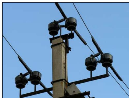
Оголовок ВЛ 10 кВ, защищённый ПЗУ КП-1Б. Фото А. Машини
