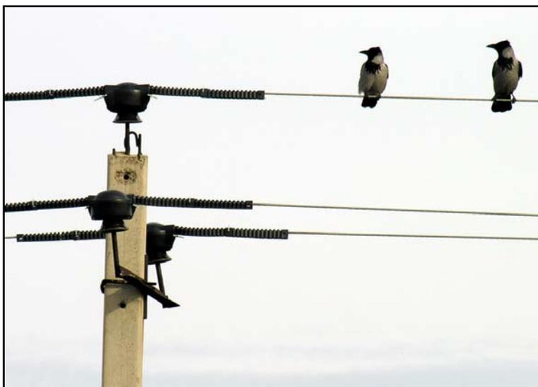
(ЛР), в результате чего токонесущий провод остался неизолированным. Таким образом, необходимо отметить высокую эффективность установленных ПЗУ. Средняя птицепасность ВЛ 10 кВ, в данном случае, составила 0,061 погибших птиц/км ВЛ.
