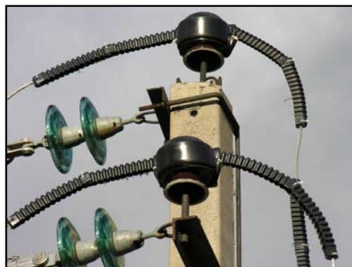
Использование гибких защитных кожухов ПЗУ КП-1Б позволяет выполнять изоляцию сложных участков токонесущего провода. Фото А. Машини
