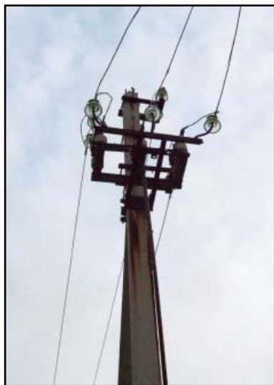
Птицепасная ЛЭП, не оснащённая птицезащитными сооружениями. Фото И. Карякина. Power line dangerous for birds without bird protective constructions. Photo by I. Karyakin.
