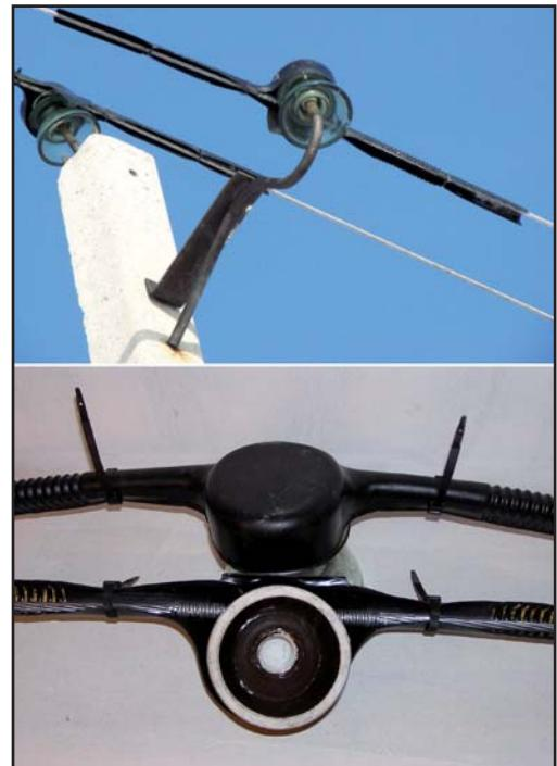
**Рис. 1.** Птицезащитные устройства для ЛЭП 6–10 кВ из модифицированного АБС-пластика на ЛЭП (вверху) и на стенде (внизу). Фото А. Салтыкова.
