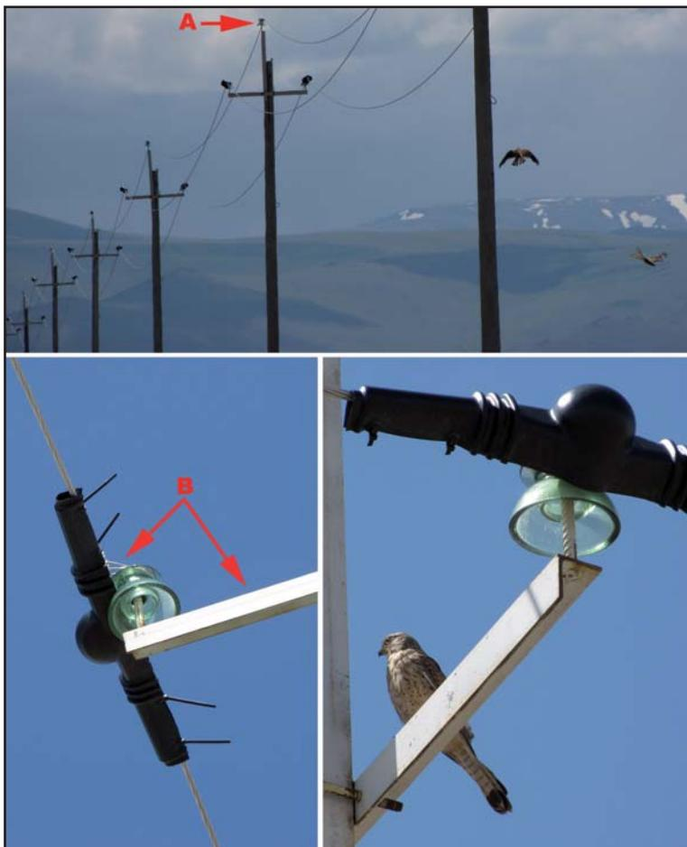
Пустельги (*Falco tinnunculus*) подвергаются угрозе поражения током на ЛЭП Кош-Агач – Бельтир в Республике Алтай, неправильно оснащённой финскими кожухами. А – верхний изолятор не закрыт кожухом. В – из-за несоответствия конструкции кожуха конструкции изоляторов имеется зона возможного контакта птицы, сидящей на траверсе, с токонесущим проводом. Фото И. Калякина.
