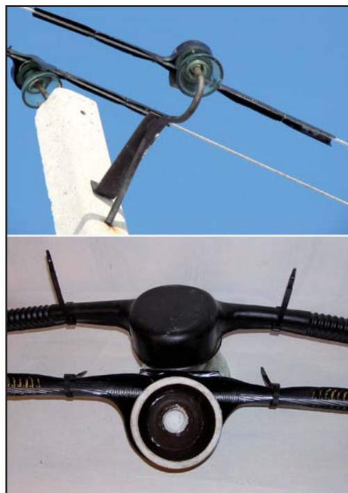
Рис. 1. Птицезащитные устройства для ЛЭП 6–10 кВ из модифицированного АБС-пластика на ЛЭП (вверху) и на стенде (внизу). Фото А. Салтыкова.
