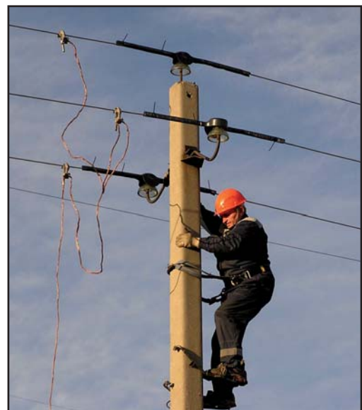
Монтаж ПЗУ на ЛЭП 6–10 кВ. Фото А. Салтыкова.
