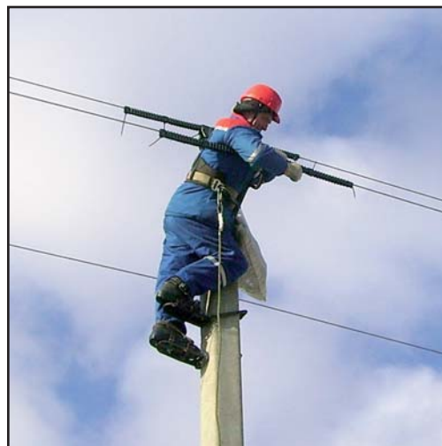
Монтаж ПЗУ на ЛЭП 10 кВ. Фото Г. Гришуткина.
