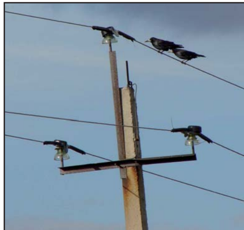
Грачи ( Corvus frugilegus ) на опоре ЛЭП, оснащённой ПЗУ ульяновского производства. Фото А. Салтыкова.
