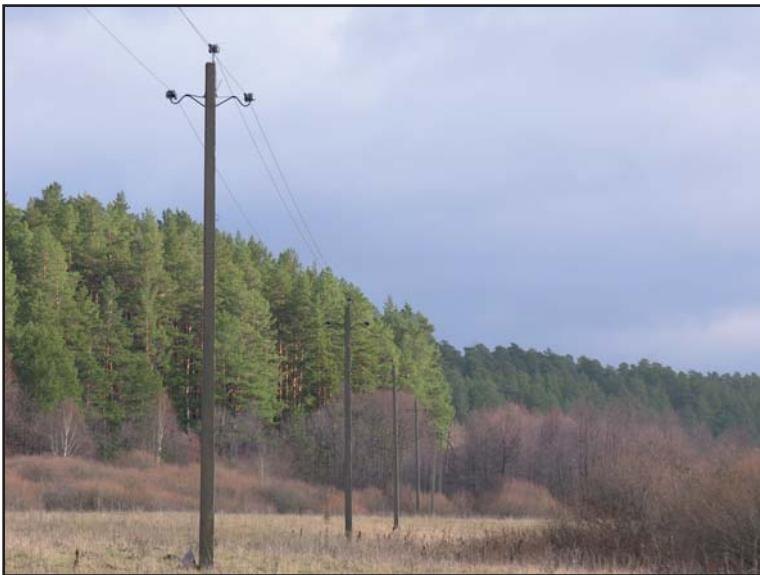
Птицеопасная ВЛ 6–10 кВ, проходящая через местообитания хищных птиц, после её оборудования птицезащитными устройствами ПЗУ КП-1Б, стала безопасной. ФГУ НП «Смольный». Фото А. Машыны.
