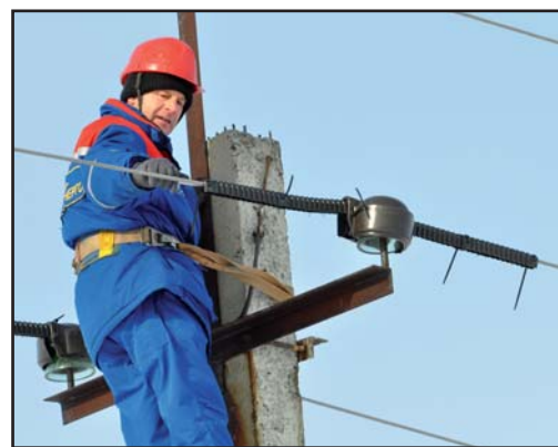
Монтаж ПЗУ в Алтайском крае. Фото А. Грибкова. Retrofitting of electric poles with bird protective devices in the Altai Kray. Photo by A. Gribkov.
