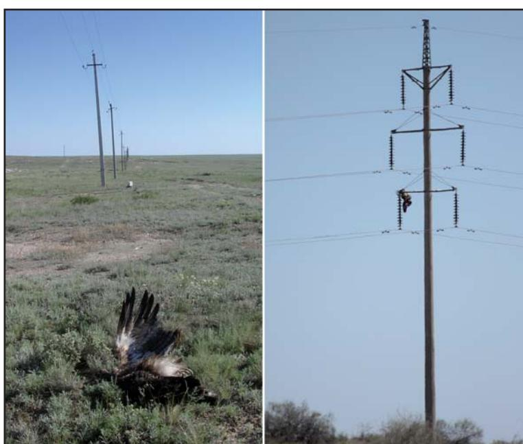
Степные орлы, погибшие от поражения электротоком на ЛЭП среднего и высокого напряжения в Арало-Каспийском регионе. Если в первом случае птица замыкает цепь, сидя на заземлённой траверсе и задевая крыльями провода, то во втором случае замыкание происходит по струе помёта. В обоих случаях опоры не имеют птицезащитных устройств, что для Казахстана является нормой.
