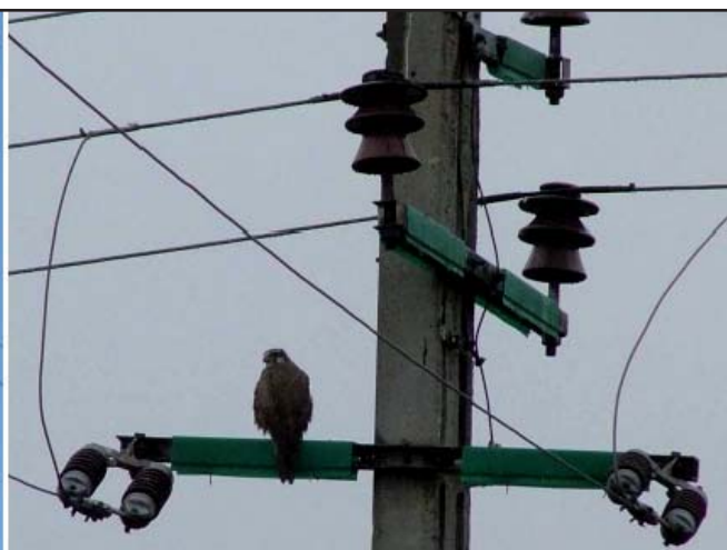
Первые решения по защите птиц на ЛЭП Венгерского общества охраны птиц в 1991–2004 гг. Фото из презентации М. Хорвата и др., 2011. The first solutions: MME develops a bird protector cross arm cover in 1991–2004. Photos from the presentation by Horvath et al., 2011.
