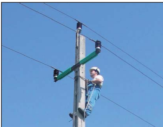
Первые решения по защите птиц на ЛЭП Венгерского общества охраны птиц в 1991–2004 гг. Фото из презентации М. Хорвата и др., 2011. The first solutions: MME develops a bird protector cross arm cover in 1991–2004. Photos from the presentation by Horvath et al., 2011.
