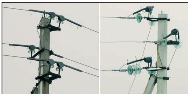
Птицеопасные ЛЭП, оснащённые птицезащитными устройствами ульяновского (слева) и нижегородского (справа) производства.
