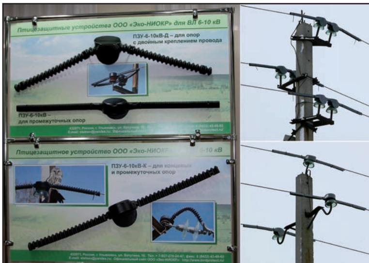
Стенд с птицезащитными устройствами, выпускаемыми ООО Эко-НИОКР (слева) и эти же конструкции на ЛЭП (справа). Фото Р. Бекмансурова.
