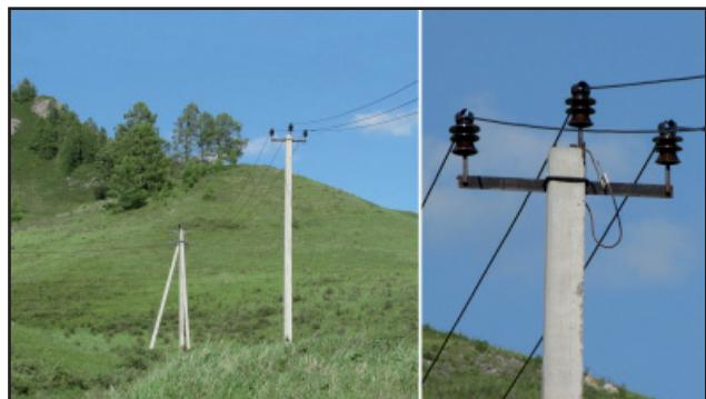
Безопасная для птиц линия электропередачи, оснащенная изолированным проводом. Алтай. Фото И. Калякина.
