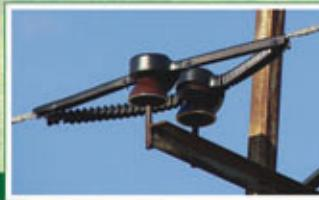
Соблюдение всех техусловий «Руководства по эксплуатации» при комплектации и монтаже ПЗУ позволяет надёжно изолировать даже самые сложные узлы крепления оголённых проводов к изоляторам птицеопасных ЛЭП.
