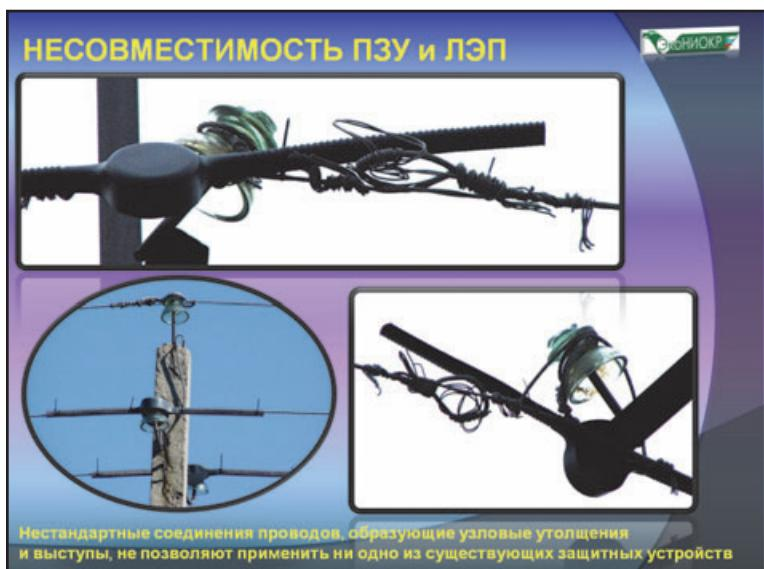
являются несоответствующий выбор модели ПЗУ, неправильное крепление изделия, неоснащение птицезащитным устройством верхнего провода, установка ПЗУ на нестандартные узлы крепления проводов.
