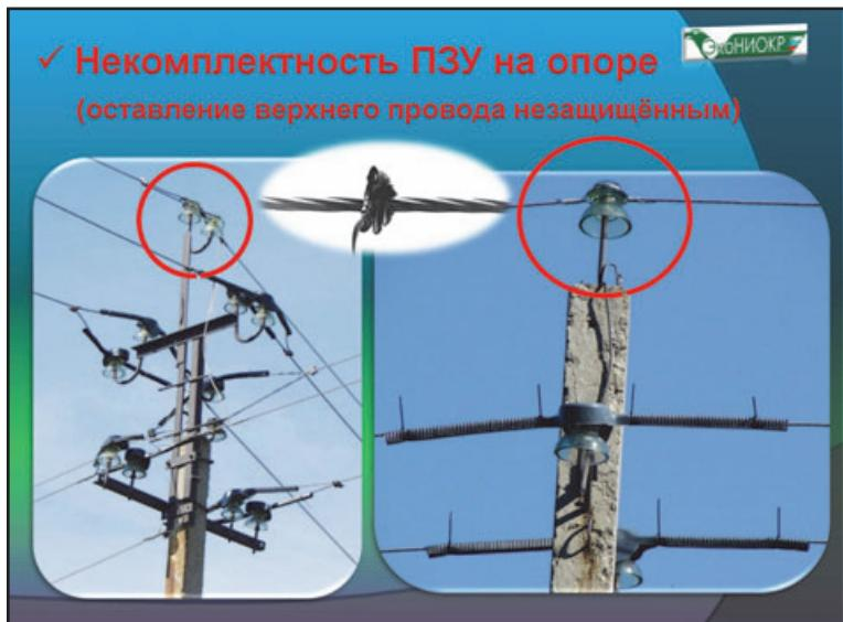
Рис. 13. Некомплектность ПЗУ на опоре.
