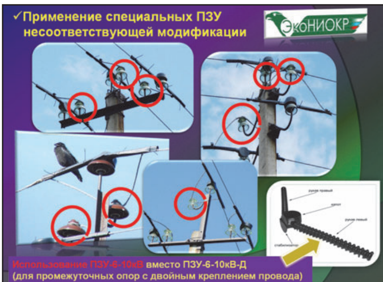
Рис. 10. Применение ПЗУ 6-10кВ вместо ПЗУ 6-10кВ-Д.
