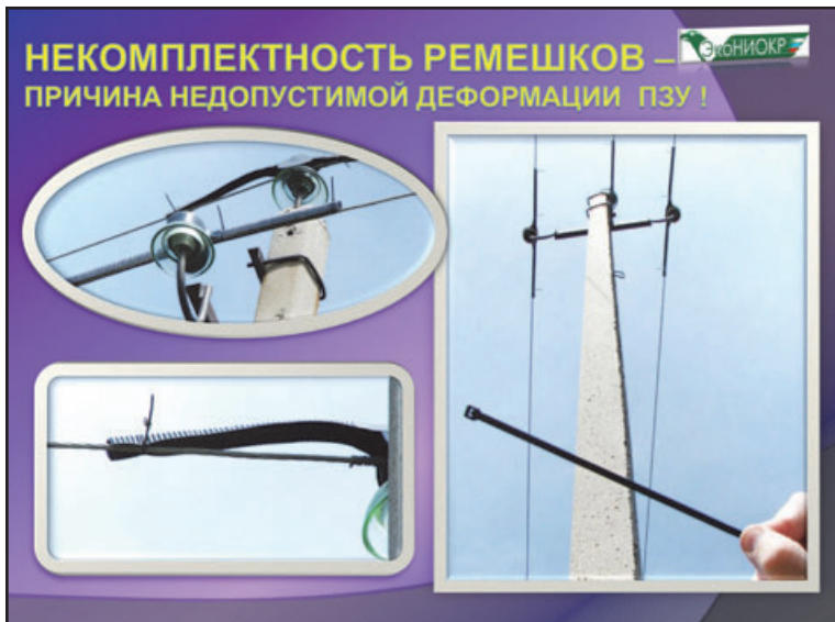
Рис. 12. Некомплектность крепёжного бандажа.
