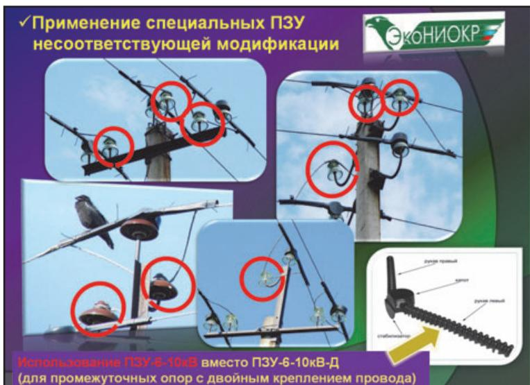
Рис. 10. Применение ПЗУ-6-10кВ вместо ПЗУБ-10кВ-Д.
