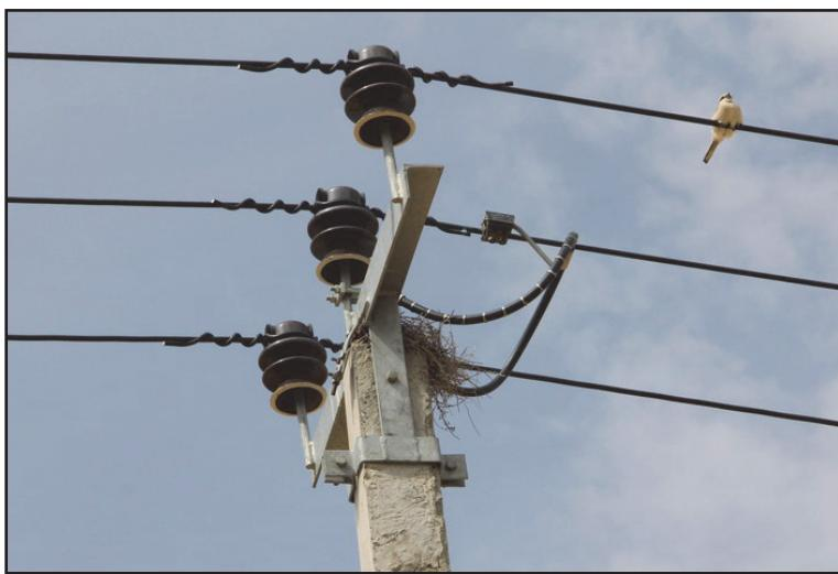
Опора ВЛ 10 кВ катодной защиты трубопровода «Тенгиз – Новороссийск», принадлежащей компании «Каспийский трубопроводный консорциум», в низовьях р. Эмба, оборудована самонесущим изолированным проводом (СИП-3) на штыревых изоляторах. Данная конструкция практически исключает возможность гибели птиц от поражения электрическим током и является оптимальной.
