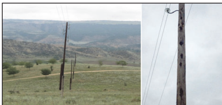
Рис. 2. ЛЭП в Табасаранском районе с деревянными опорами (справа – опора ЛЭП, повреждённая дуплогнёзниками).
